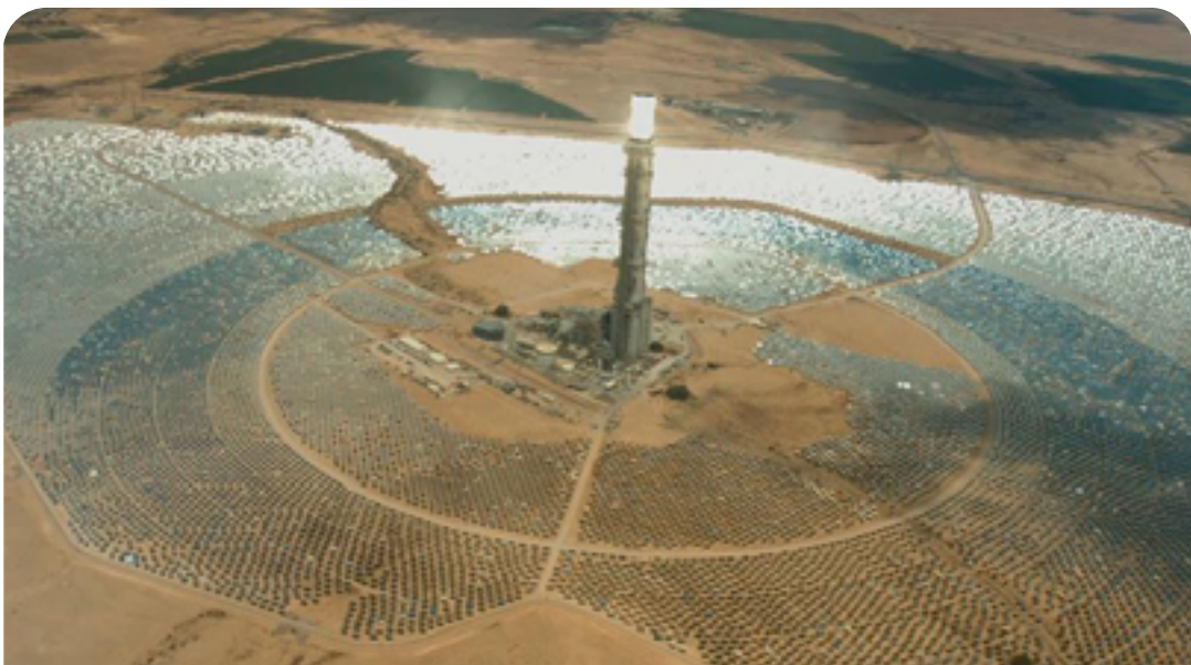
Central solar térmica de Ashalim en el Neguev
