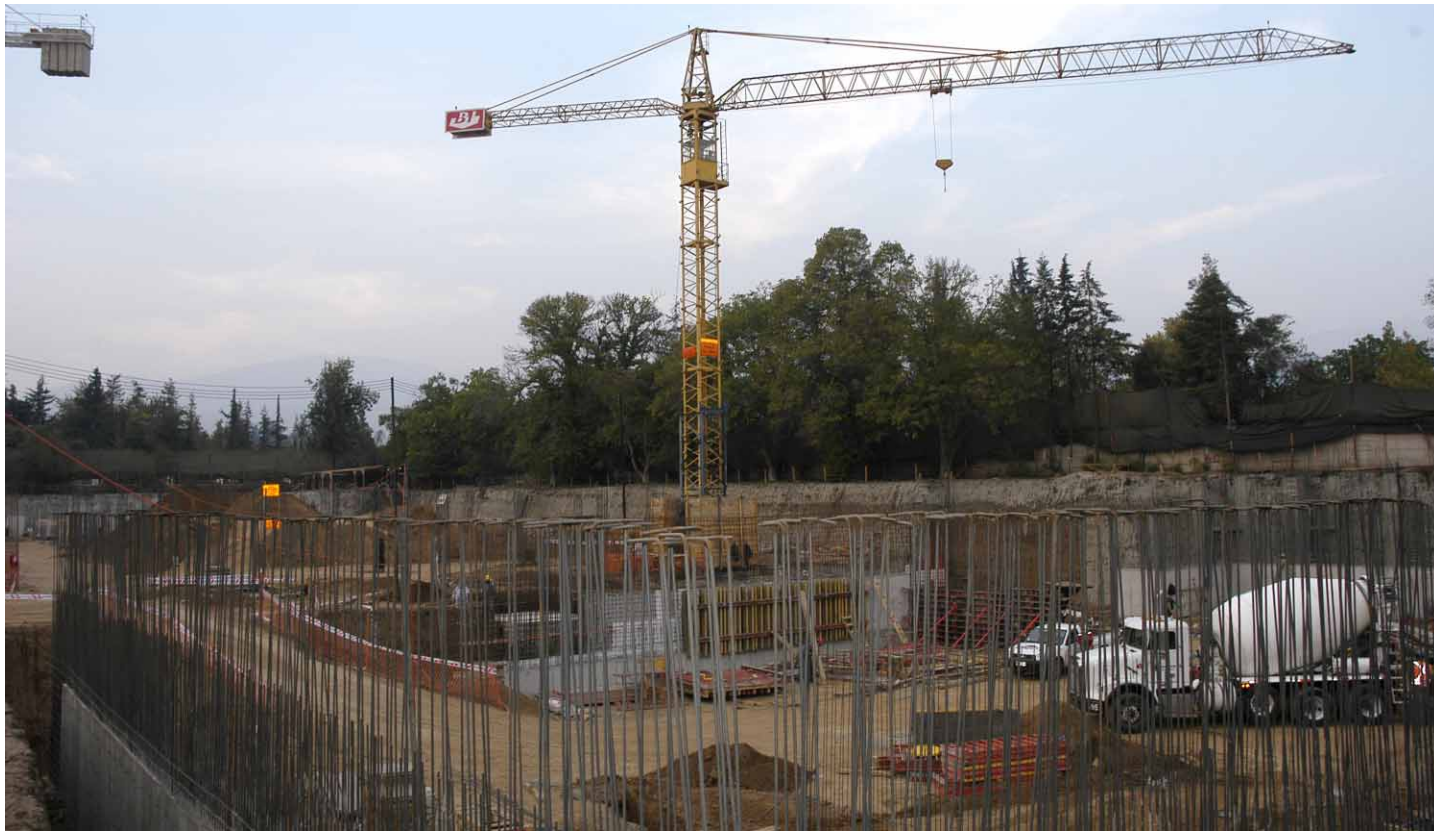
UN ASPECTO DEL AVANCE DE LA OBRA.
